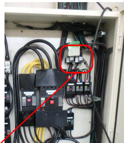
変成器付計器(左)とCT(上)を設置
